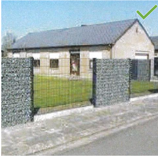
Alternance de grillage rigide et de mur en gabion = dispositif non-opaque
