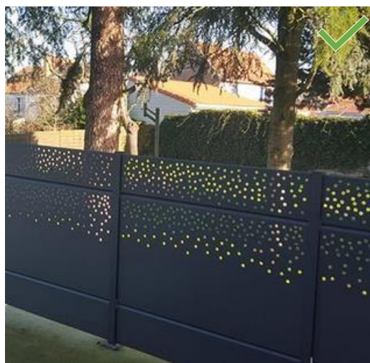
Panneau ajouré avec 25% de lumière répartis = dispositif non opaque
