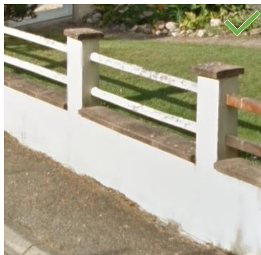
Mur-bahut surmonté de lisses (dispositif non opaque)
