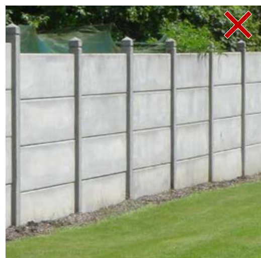
Mur plein avec plaques de béton = dispositif opaque
