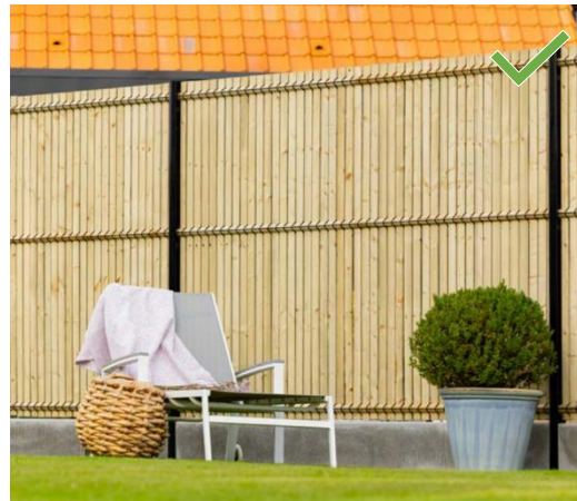
Occultation d'un grillage rigide réalisé en brise-lame de bois (autorisée en secteur 2)
