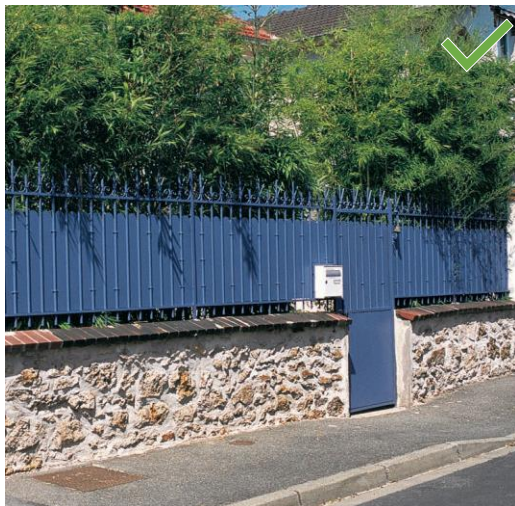
Mur-bahut surmonté d'un barreaudage en ferronnerie et d'un dispositif occultant (festonnage). Un espacement doit être prévu entre le muret et le festonnage, ainsi qu'au niveau de la traverse haute de la grille (=25% minimum de lumière).
