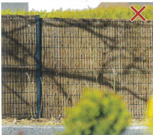
Occultation d'un grillage rigide réalisé avec des brandes de bruyère = dispositif opaque
