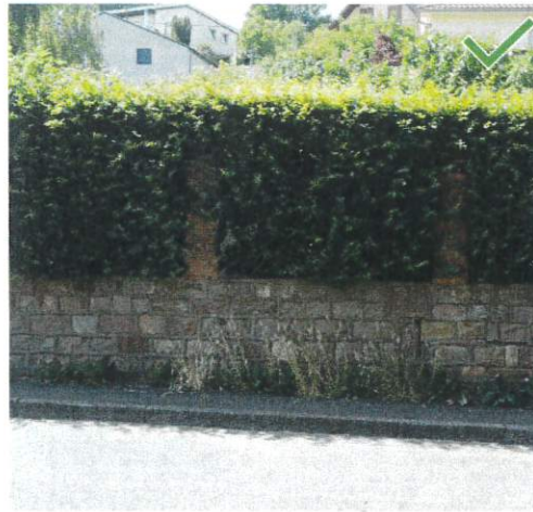
Mur-bahut en pierre doublé d'une haie végétale
