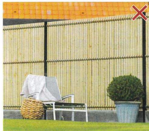
Occultation d'un grillage rigide réalisé en brise-lame de bois = dispositif opaque
