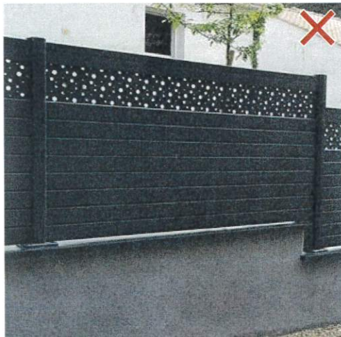
Panneau avec 25% de lumière non répartis sur le panneau = dispositif opaque
