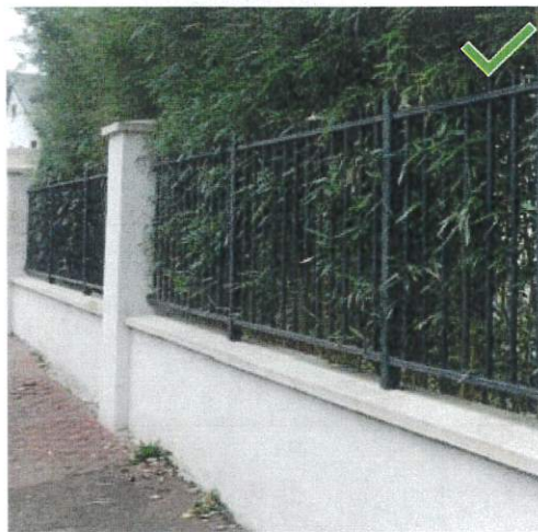
Mur-bahut surmonté d'un dispositif de claire-voie non opaque avec un barreaudage en ferronnerie de conception simple et doublé d'une haie vive végétale
