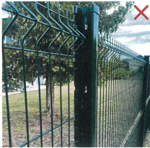
Clôture en grillage rigide
