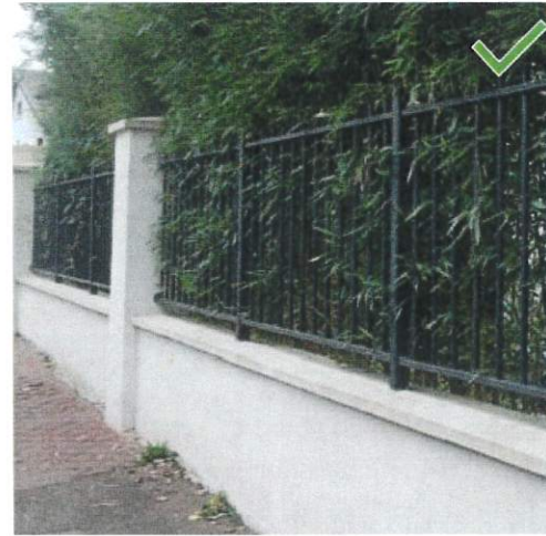
Dispositif de claire-voie non opaque avec un barreaudage en ferronnerie de conception simple et doublé d'une haie vive végétale
