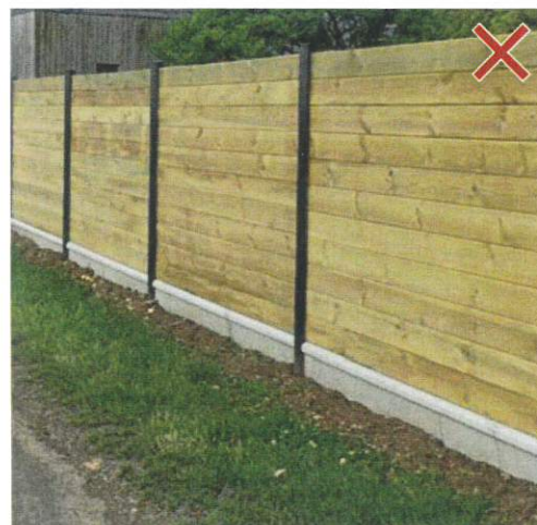
Palissade non ajourée = dispositif opaque Plaques de soubassement intégrées : limite le passage de la petite faune
