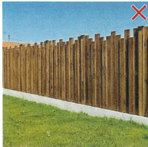
Palissade en traverse de chemin de fer sans interstices = dispositif opaque
