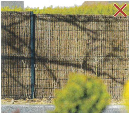
Occultation d'un grillage rigide réalisé avec des bandes de bruyère = dispositif opaque
