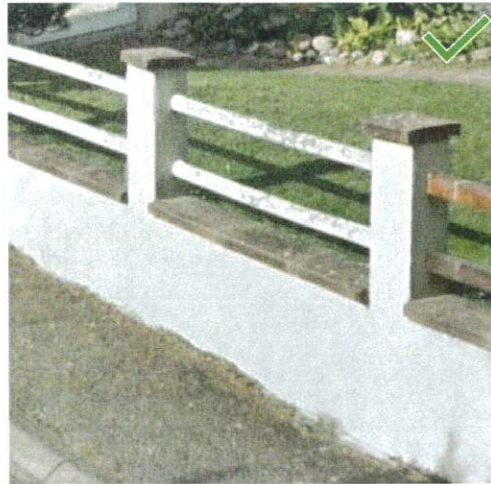
Mur-bahut surmonté de lisses (dispositif non opaque)
