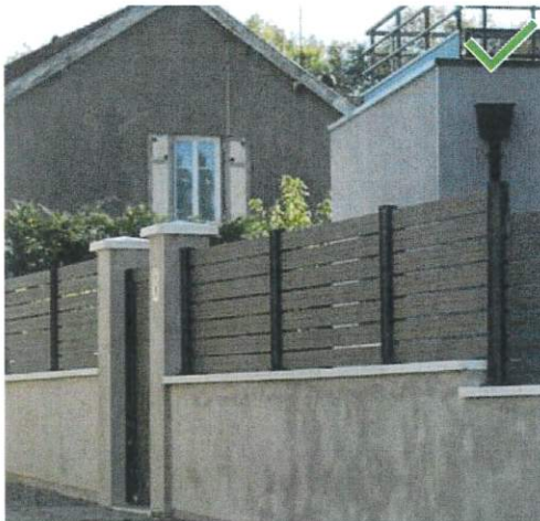
Mur-bahut surmonté d'un dispositif de type claire-voie / Couleurs en harmonie avec l'environnement 4 à 5cm au minimum entre les lamelles
